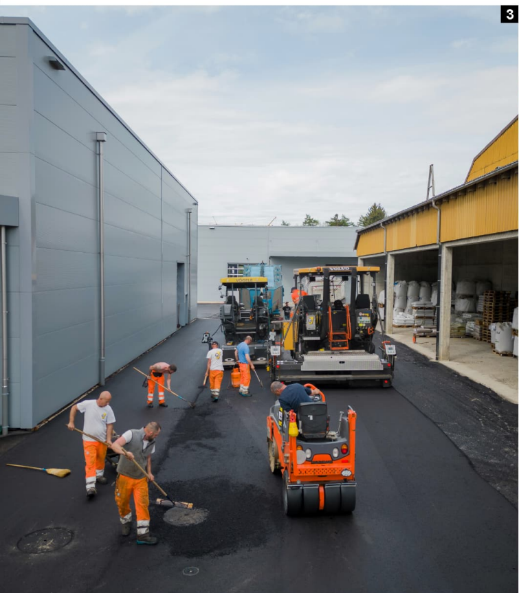
1. Sciage des raccords en enrobé 2. et 3. Pose d'enrobé main et machines
