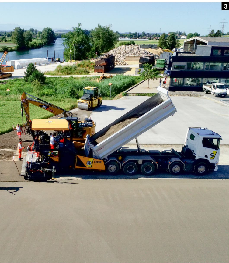
1. Installation et stockage pour la fabrication du Marti Ecobitu 10/25 2.-3. Pose du Marti Ecobitu 10/25
