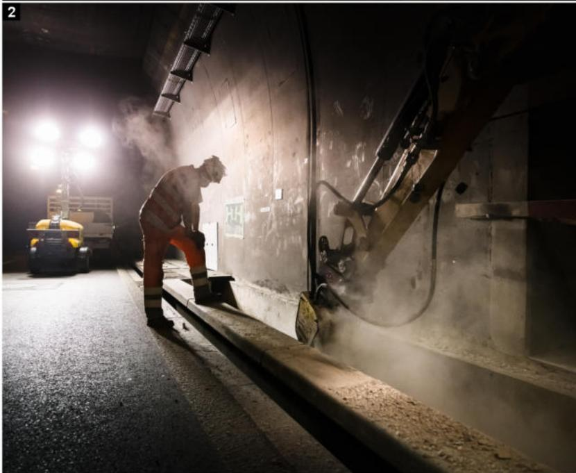
1. Mise en place de fixation dans la voûte pour changements des trappes d'accès
